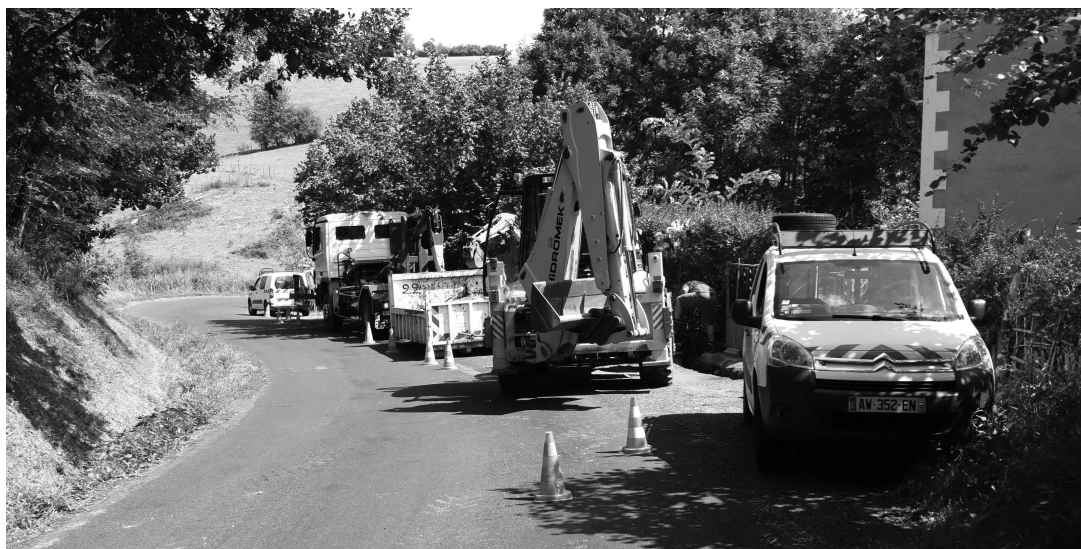
Travaux en régie : renouvellement d'une canalisation de branchement (Estandeuil)
